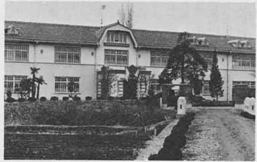
校舎全景（昭和12年）
