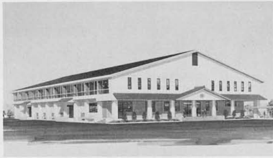
建設中の新体育館
